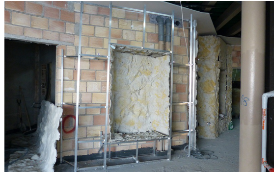
Bewährt haben sich Unterkonstruktionen aus Aluminium-Vierkantrohren
