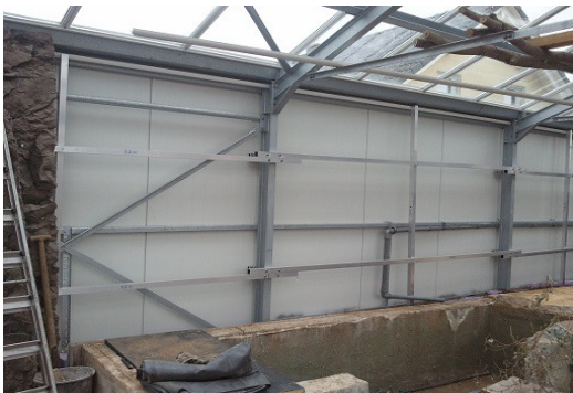
Bewährt haben sich Unterkonstruktionen aus Aluminium-Vierkantrohren
